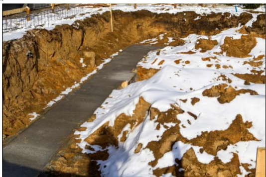
图 1 冬季土木工程施工冻害
