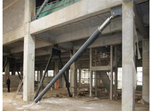
图1：大楼阻尼器的设置示意图
