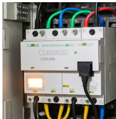
图 1 欠压保护继电器及时动作图
