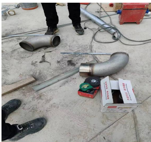
图二: 采用砂轮锯切割钢管
