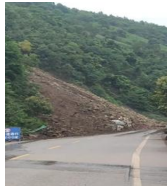
图 1.1 抗剪强度不足引起坡脚滑动
