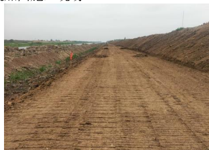
图 2：堤防填筑现场
