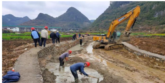
图一，水利工程施工
